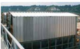
Capotage de protection : une solution rationnelle, pour s'affranchir des fluctuations climatiques, qui s'intègre dans l'environnement de l'installation.
