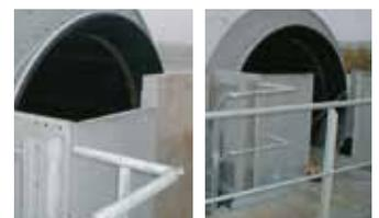
L'accès à l'intérieur du tambour débourbeur est aisé et sécurisé grâce à un pont basculant.
