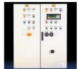
Schaltschrank für die einfache manuelle Bedienung des Kipplifts oder den Automatik-Betrieb in Kommunikation mit der Steuerung eines Wiegesystems für eine Ofenbeschickungsanlage.
