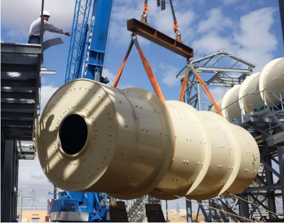
Montage af roterende vasketromle.
