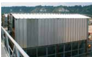
Einhausungen zur Anpassung an die Umgebung sowie zum Schutz der Anlage.
