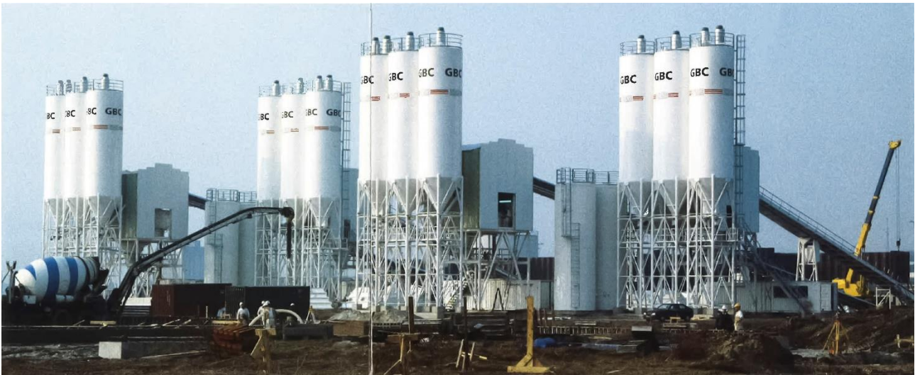
Fire identiske SKAKO-blandeanlæg til Storebæltsbroen.
